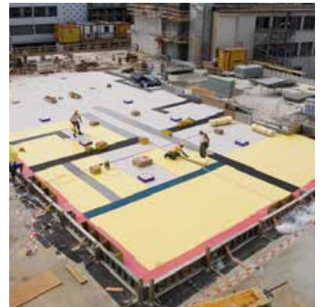
Suspensión flotante de un edificio con SYLOMER
